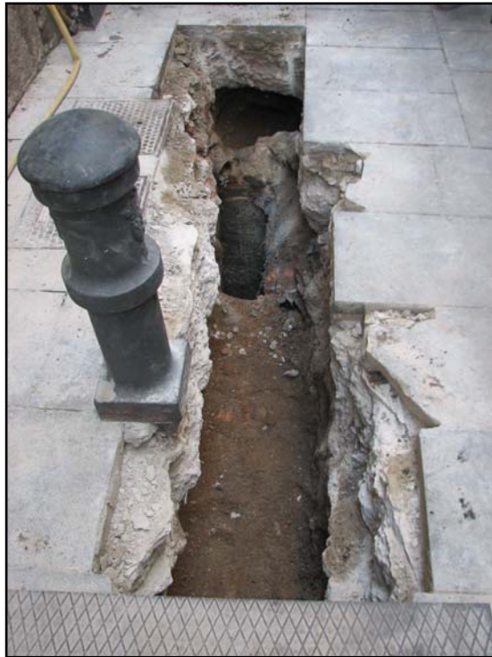
Foto 3: Inici de la rasa 200
